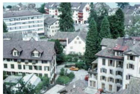
1986: Rosenhof mit den beiden Gebäuden: Verwaltung (links), Lehrerbüros und Laborräume (rechts)
