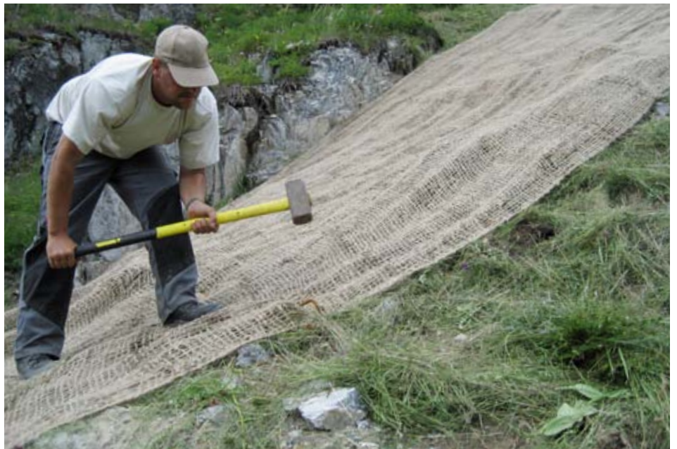
Fixierung eines Kokos-Gewebes als Erosionsschutz (Bild: M. Schwager)
