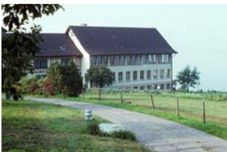
1974: Schulgarten für studentische Übungen im Gemüsebau im Erdgeschoss die Laborräume
